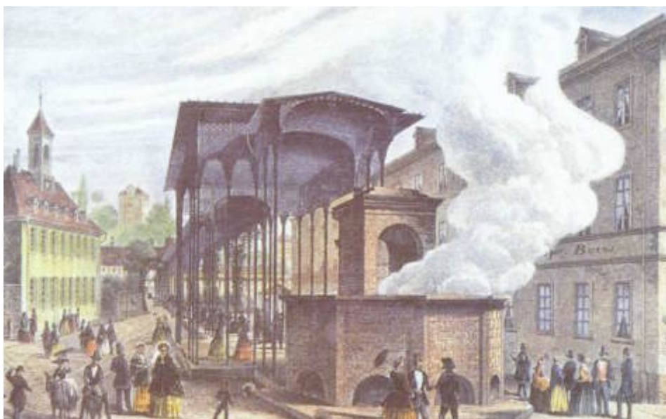
Kochbrunnen mit eiserner Wandelhalle um 1856. Die Wandelhalle führte zum Kranzplatz. Das „Römerbad“ ist rechts im Bilde zu sehen.
